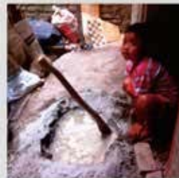
道でセメントを練っても構わない。 ここは私有地だから。
